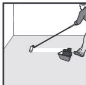
Étendre le produit de maintien (poissant/fixateur) au rouleau selon les préconisations du fabricant.
